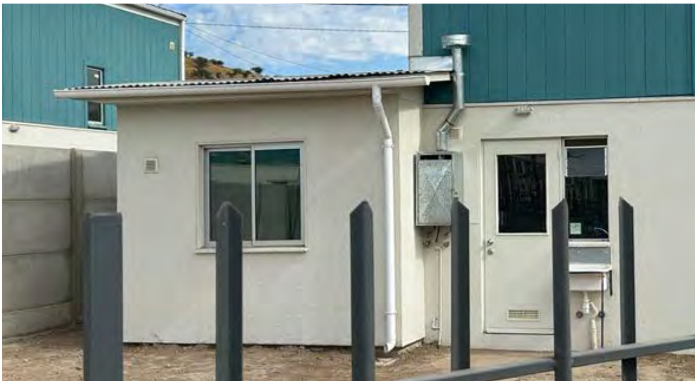
FLP contribuyó a la ampliación de 51 casas del proyecto Costa Azul, en la comuna de Puente Alto.
