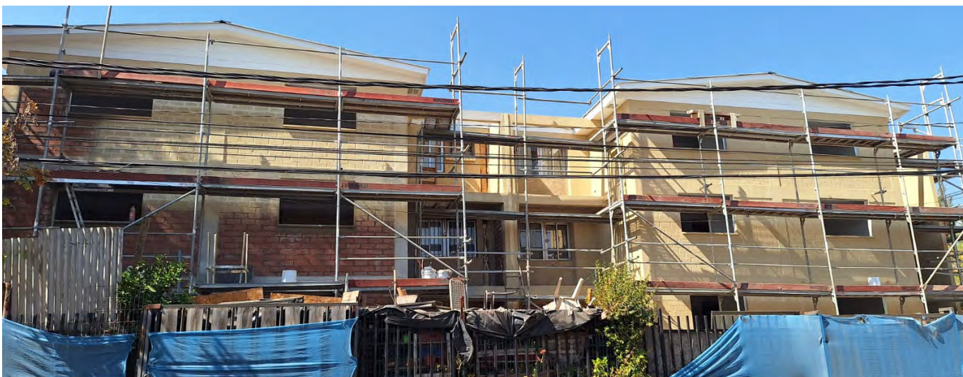
Proyecto Santa Teresa, ubicado en La Florida, donde la Fundación donó las obras de instalación eléctrica para poder llevar a cabo el proyecto.
